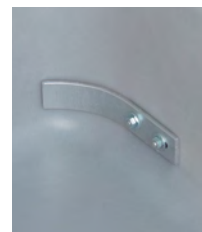
Fijación de la plataforma (refuerzo)
